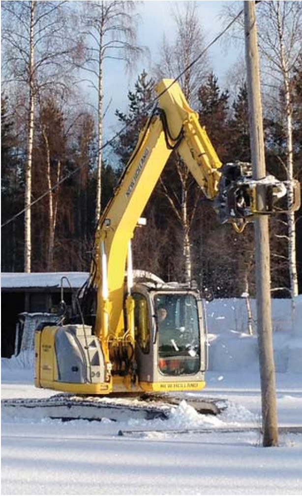
Raution vedenottamoilta uusittiin sähkölinjoja.
