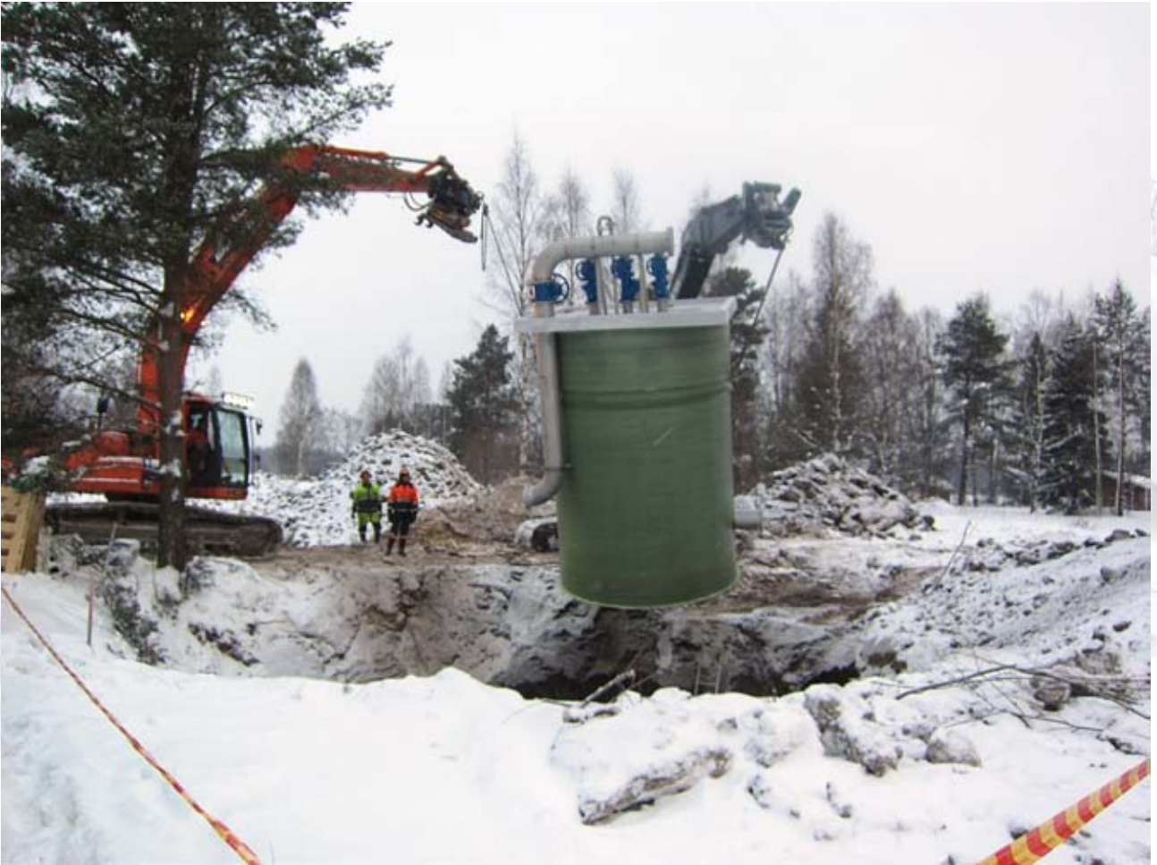
Haapajärvi–Nivala -siirtoviemäriin jätevesipumppaamon asennus käynnissä.
