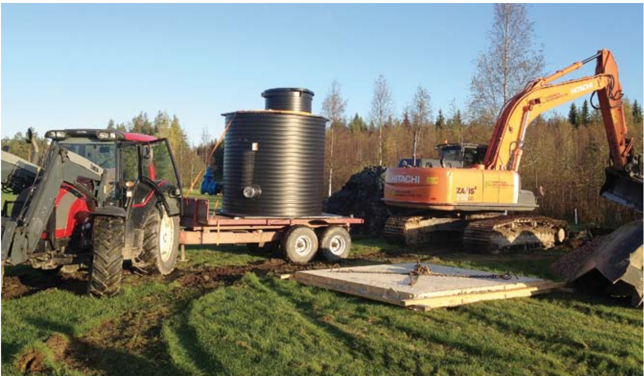
Papinoja–Ravirata -yhdysvesijohdon laitekaivo asennettiin Nivalan golfkentälle.
