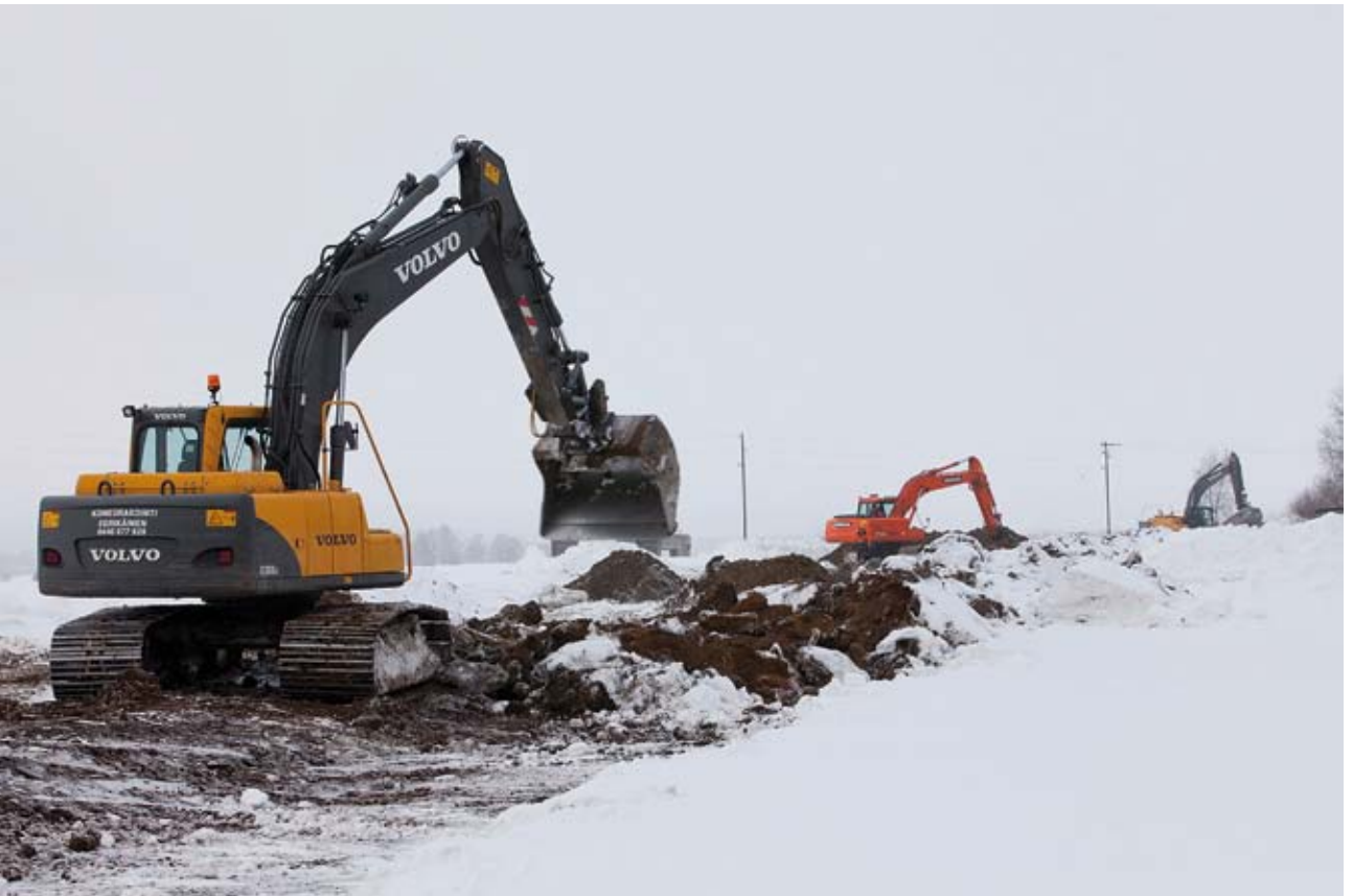
Haapajärvi–Nivala -siirtoviemäriä rakennettiin 26 kilometriä 315 mm PEH-putkella.
